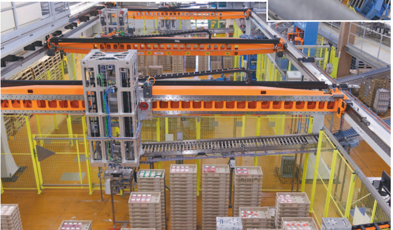
Die Gebinde laufen auf Rollenbahnen zu den Portalen und werden anhand ihrer Etiketten identifiziert. Die Portalroboter stellen die Gebinde zuerst auf vordefinierte Filial-Kommissionierplätze und stapeln sie dann auf die bereitstehenden Paletten. (Bilder: Siemens)
